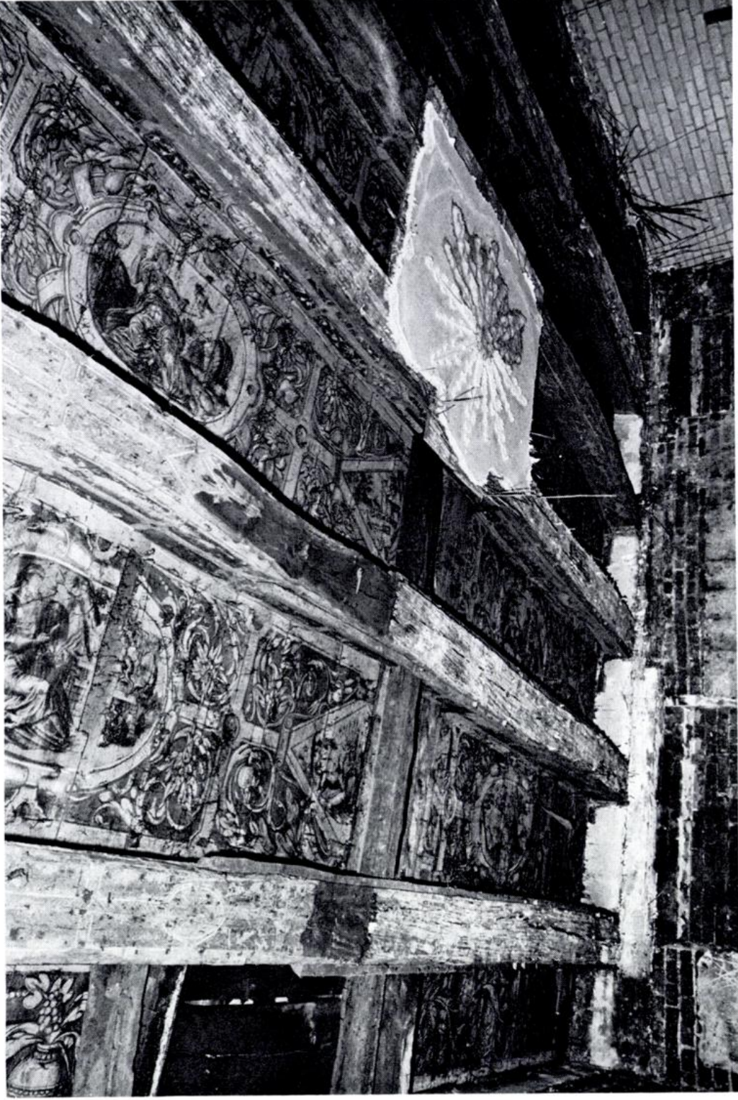
Abb. 2: Decke im Haus Heineken während der Freilegungsarbeiten, rechts mit dem Mittelstück der Stuckdecke von 1744.
