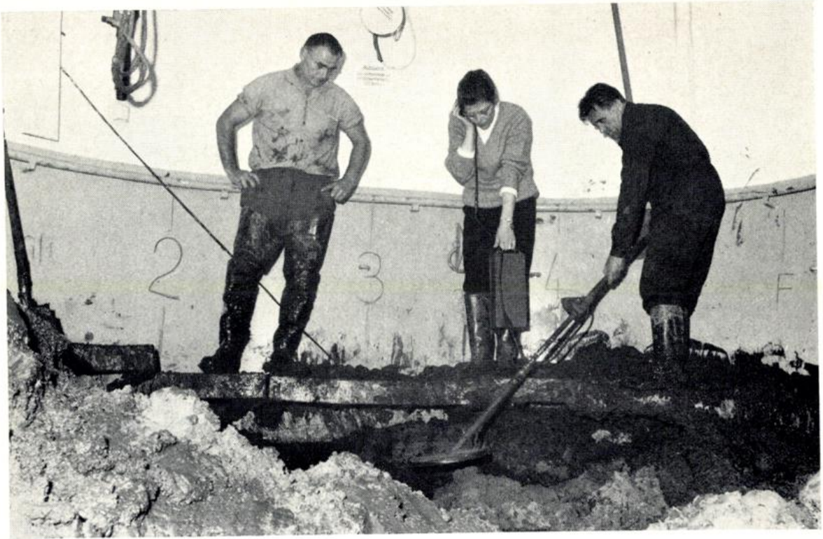
Arbeiten in der Taucherglocke. Mit einem Minensuchgerät wurde der Boden auf Eisenteile untersucht.
