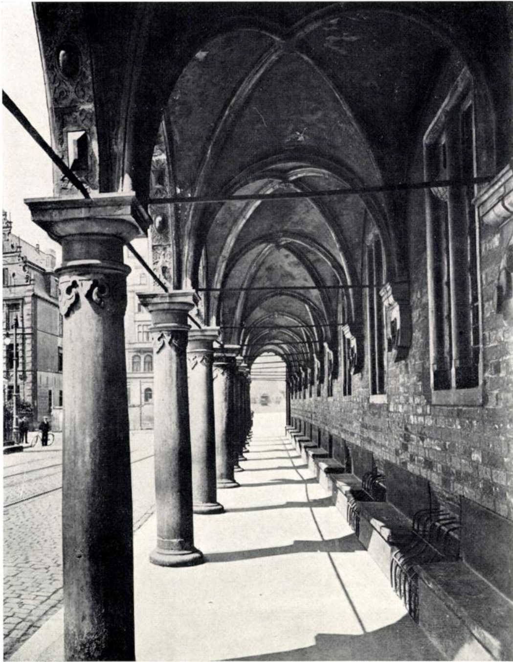
Verschiebungen innerhalb der Säulen der Rathausbogen. Die vierte Säule von links vorn, die erste der vier dicken Güldenammer-Säulen, ist mit ihrem Kapitäl in Reih und Glied mit den andern geblieben, während ihre Basis sich nach vorn bewegt hat und etwas vor die Front getreten ist (zu S. 127).
