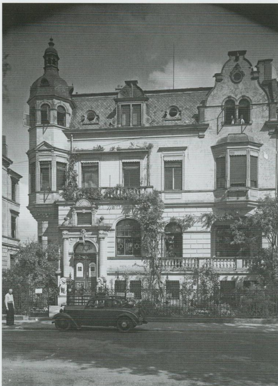
Abb. 6: Die Villa Osterdeich 17, 1945 durch die Alliierten als Gemeindehaus und Synagoge der jüdischen Gemeinde Bremen zugewiesen. Aufnahme von Alfred Nawrath, Sommer 1947. (StAB 10,B FS 27)
