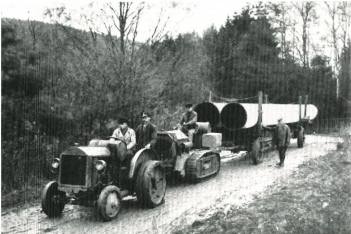
Abb. 4: Transport von Rohren zur Verlegung. Foto 1934. Mannesmann-Archiv
