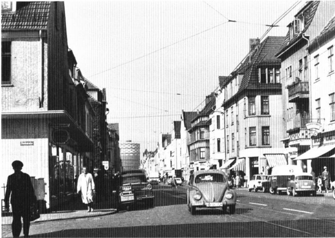
Abb. 3: Auch aus der Bremer Neustadt war das Industriegebäude auf der Sichtachse der Gastfeldstraße deutlich zu sehen. Quelle: StAB 10 B-1962-102.
