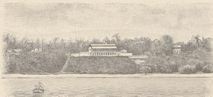
Tanga-Stationengebäude 236° (SWzW) 0,7 Sm.
