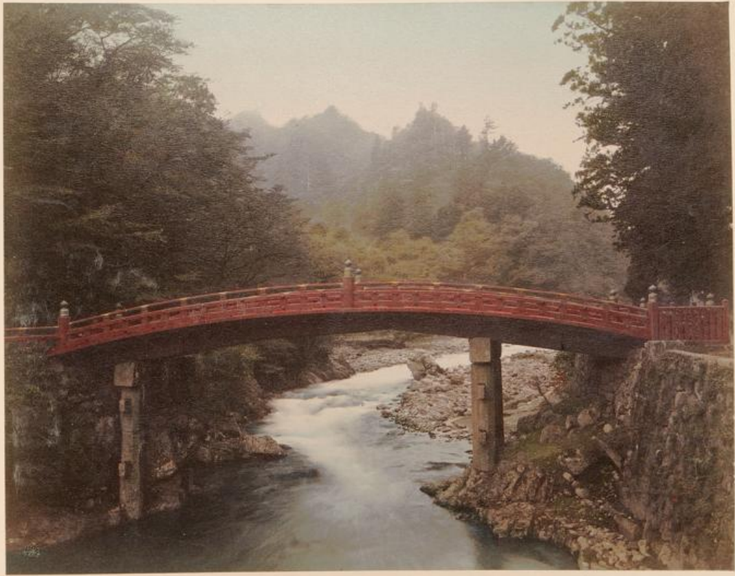
holz. brücke - Kikkō
