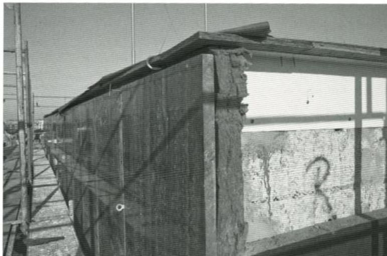
Dämmung und Aufbau der neuen Magazinfassade.
