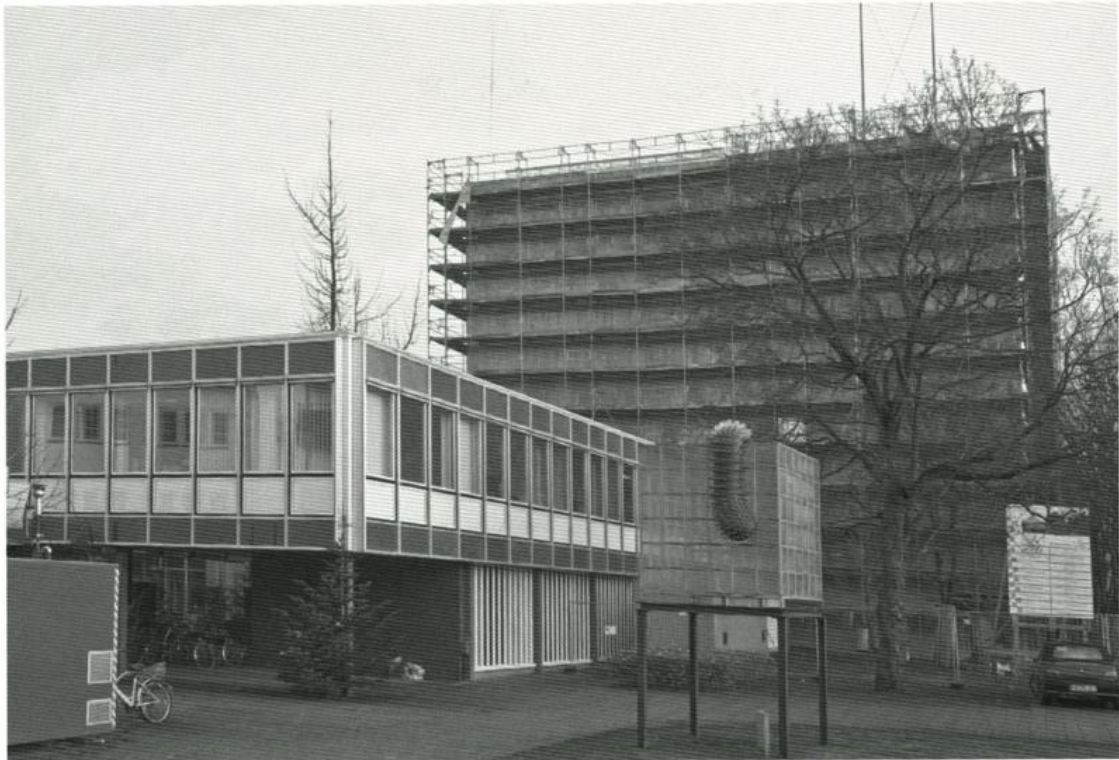
Fassade des Verwaltungsbaus nach der Sanierung, im Hintergrund der eingestülpte Magazinturm des Staatsarchivs. (Fotos: Koetzle StAB)
