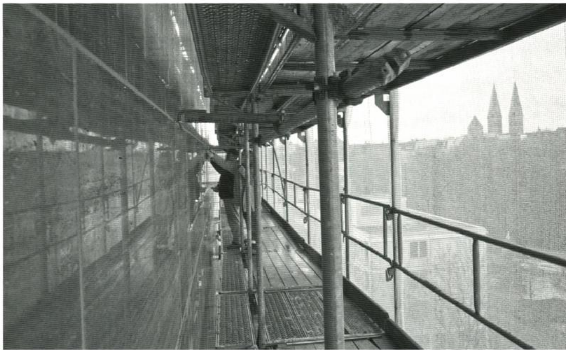
Verfugen der neuen Travertinplatten.
