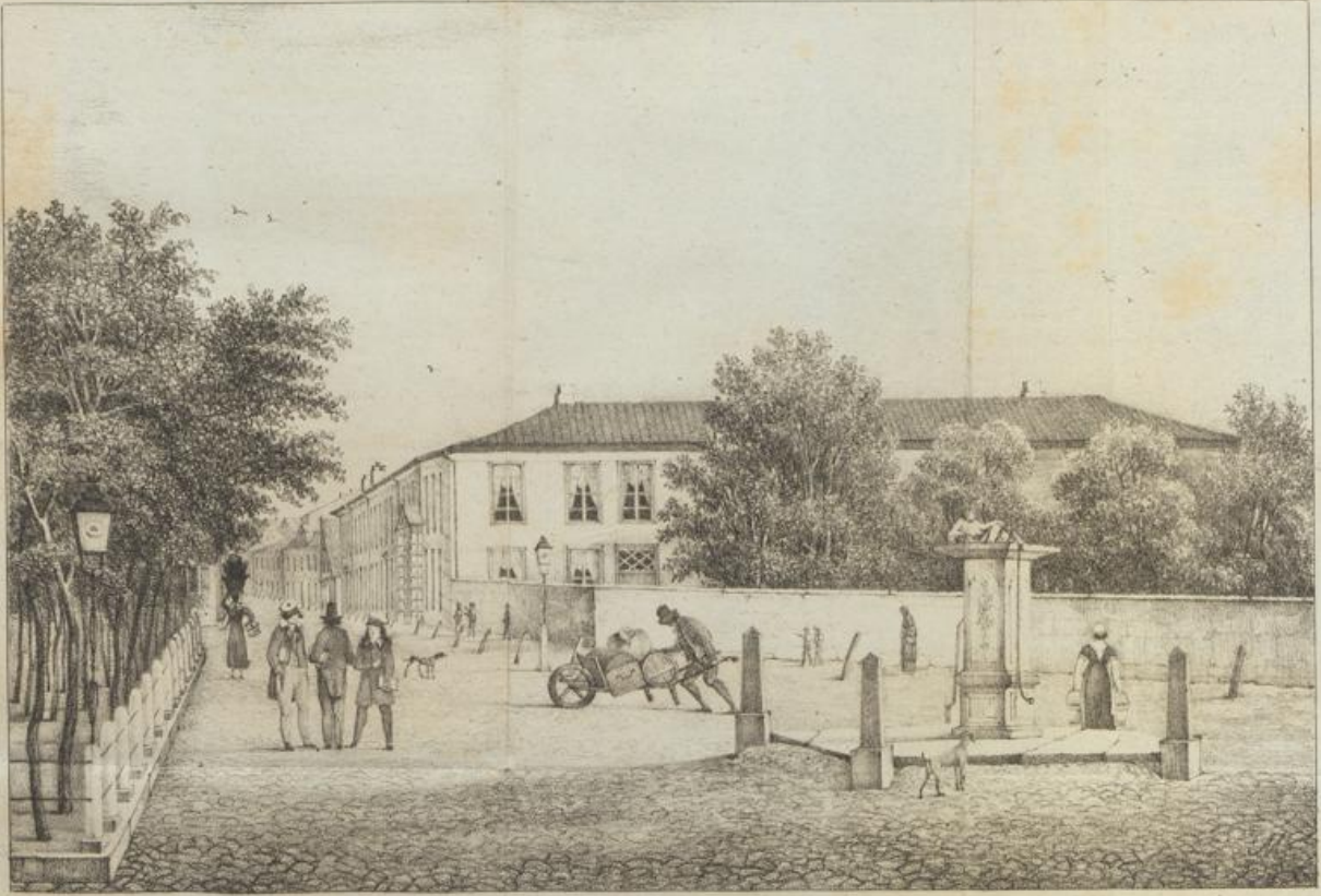
Ansicht des neuen Schulgebäudes an der Darschule in Bremen
