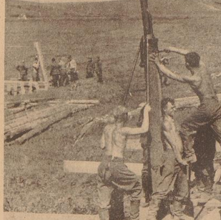
R.A.D. im Osten. Schnell und doch zuverlässig müssen der vorstürmenden Truppe Brücken gebaut werden. Mit Hilfe von Maschinen werden in kurzer Zeit die Brückenpfeiler in die Erde getrieben und bald steht auch diese Brücke dem Vormarsch zur Verfügung. Bildbericht von Hansmann (Sch.).
