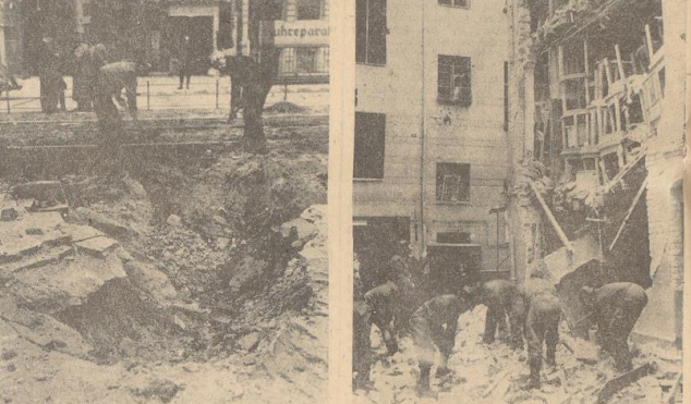
Ein Bombenkrater in einem anderen Berliner Vorort, in dessen näherer Umgebung sich gleichfalls keinerlei militärische Ziele befanden.
