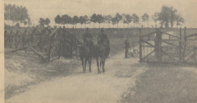
Links: Da hämmert überfallig ein MG, aus dem nahen Brückenpfeiler... Rechts: Lücken durch das Hindernis waren festgelegt
