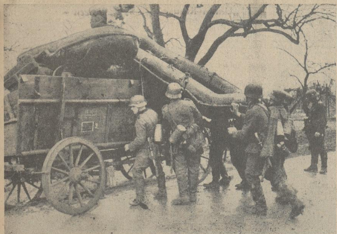
Kompanie wird mit Schlauchbooten übersetzt. Die zur Übersetzung benötigten Schlauchboote werden verladen
