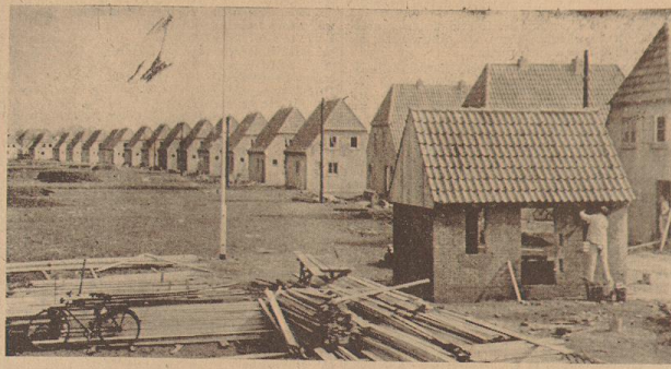
Blick auf die Rückseite der Siedlung. Im Vordergrund ein Stallgebäude, das leicht um eine KAP-Wagen-Garage erweitert werden kann.
