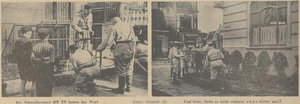
Die Schneidbrenner der TN haben das Wort
