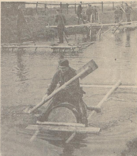
Fahrt auf einer sachgemäß gearbeiteten Spinnle. Im Hintergrund die Pionierkameraden beim Bau eines festen und eines schwimmenden Laufsteiges
