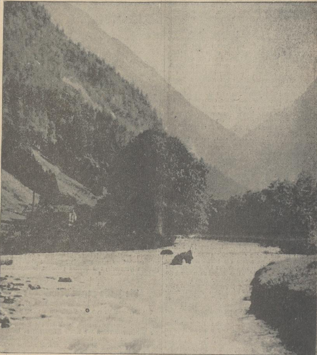
Hier, in der Nähe von Zell am See, tat Generalfeldmarschall Göring den ersten Spatenstich für den Bau des großen Wasserkraftwerkes. (Presse-Hoffmann)
