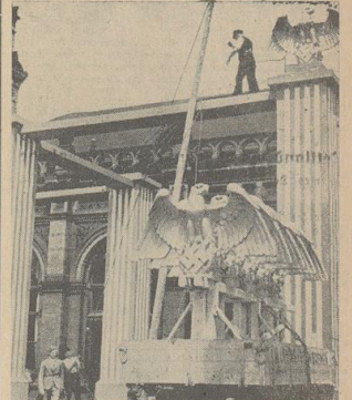
Die Pylonen vor der Front des Bahnhofgebäudes erhalten ihre Bekrönungen.
