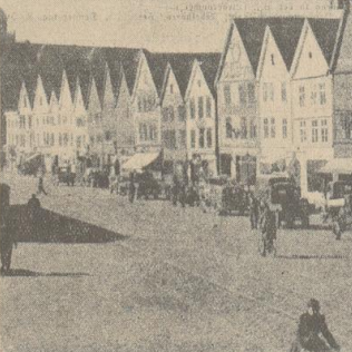
Bergens Kleinstadt: Die Tyskebyrggen
