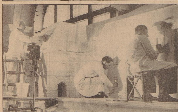
Zum heutigen Arbeitsbeginn der Neugestaltung Berlins. In der Dienststelle des Generalbauinspektors für die Reichshauptstadt am Pariser Platz werden unter Leitung von Professor Albert Speer nach dem Plan des Führers die Einzelheiten für die Bauten zur großartigen Umgestaltung der Reichshauptstadt ausgearbeitet. — O.B.E.N.: Ein Ausschnitt aus einem Arbeitsraum, wo die Mitarbeiter Professor Speers riesige Einzelkarten und Pläne bearbeiten. — U.N.T.F.E.N.: Ein Modellstück des Erweiterungsbauwerks der Reichskanzlei im Maßstab 1:10 wird hergestellt, um die architektonische Wirkung des Entwurfs besser beurteilen zu können. — Aufnahmen: Presse-Hoffmann (2).
