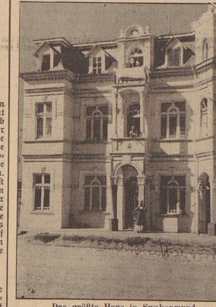
Das größte Haus in Swakopmund
