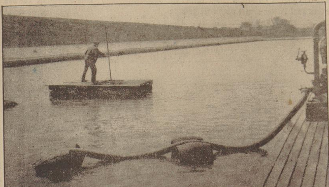
Vom Floß aus wird der Saugkorb bedient. Das Floß liegt zwischen mehreren Leinen fest und kann Stück für Stück weitergezogen werden, so daß alle Stellen des Bades auch wirklich gereinigt werden.
