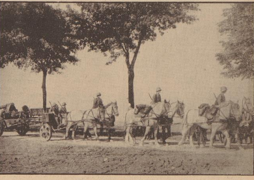
Schwere Artillerie rückt vor Aufnahmen: Schmidt (2)
