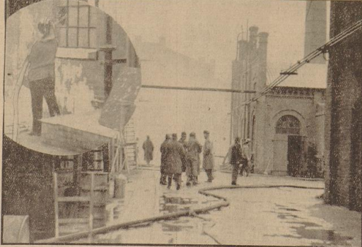
Unser Bild zeigt einen Blick auf den Hof der Mineralöl-Raffinerie während des Brandes. Der ganze Brandhof und seine Umgebung schwammen schließlich im Schmelz, der von unserer Feuerwehr als Löschmittel wirksam angewandt wurde. Auf: Heil (2)
