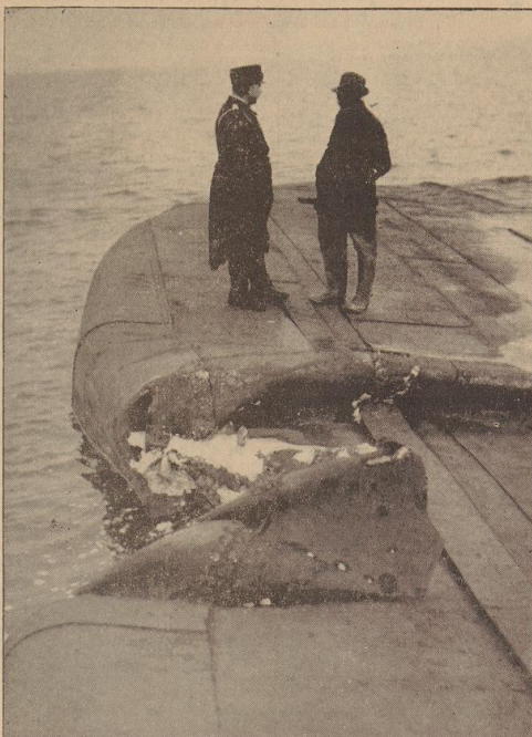
Deutlich ist das Leck und seine Größe erkennbar
