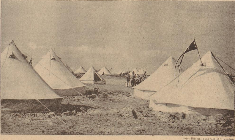
Foto: Bildstelle HJ-Gebiet 7, Nordsee
