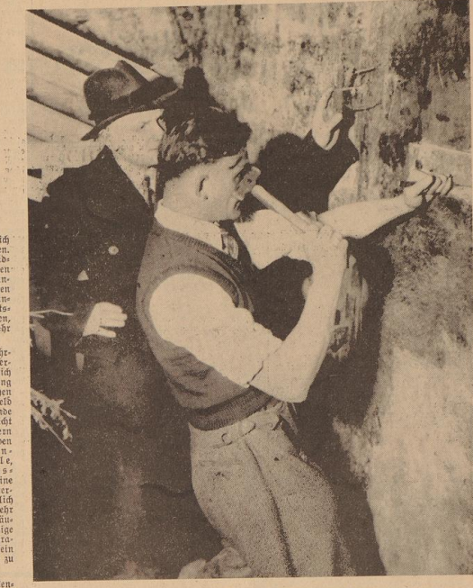
Hoohspannung: Die erste vermauerte Tür der Comthurei wird vorsichtig angeschlagen!
