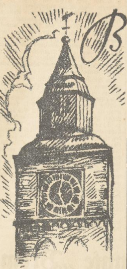
Der Südturm des Domes vor dem Umbau
