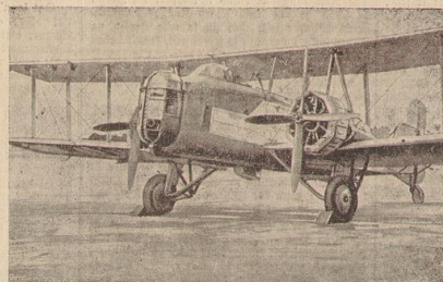
Der stiegende Panzerturm. Das englische Luftfahrtministerium hat eine große Anzahl dieser neuen Bombenwerfer in Auftrag gegeben, die sich durch einen Panzerturm auszeichnen, der vor dem Piloten montiert ist. Das darin befindliche Maschinengewehr kann auch bei einer Stundengeschwindigkeit von 300 Kilometer stündlich nach allen Seiten feuern.
