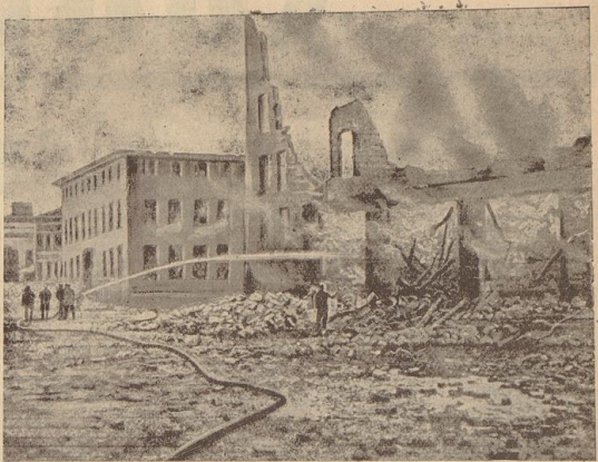
Ein Foto von dem furchtbaren Hotelbrand in der nordamerikanischen Stadt Lansing. Man sieht das bis auf die Grundmauern niedergebrannte Gebäude. Feuerwehrlöcher vergrößern gegen das entsetzte Element. Wie bekannt, hat das Unglück bereits über 30 Todesopfer geerntet. Man fürchtet jedoch, daß die Zahl der Toten auf 100 steigen wird, da viele Gäste vermisst werden.
