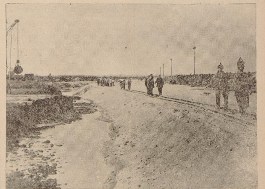
Fundamentierungsarbeiten am Schwarzen Weg in Gröppeligen
