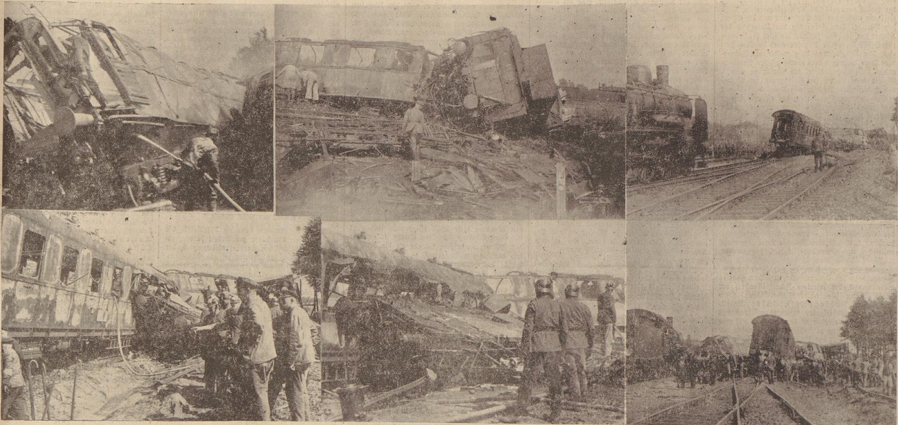
1. Einer der entgleisten Personenwagen — 2. Tender und Lokomotive — 3. Die Wagen werden abgeschleppt — 4. Rettungsarbeiten am 2-Klasse-Wagen — 5. Die Überreste des Speisewagens — 6. Die aufeinandergefahrenen Wagen
