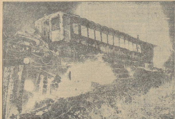
Benzin-Lokomotive veruracht Eisenbahnbrand.
