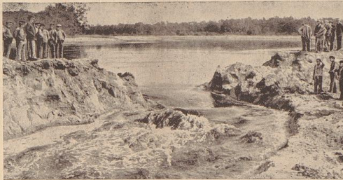
Oberhalb von Rostock ist die berühmte Krümmung der Elbe durch ein neues 800 Meter langes Flußbett befreit worden. Die Krümmung hat die Elbschiffahrt bisher sehr behindert. Unter Bild hält den Augenblick fest, da sich die Kesselmauern der Elbe in das neue Flußbett füllen.
