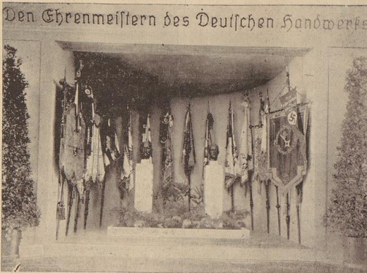
Der Ehrenhof des Handwerks
