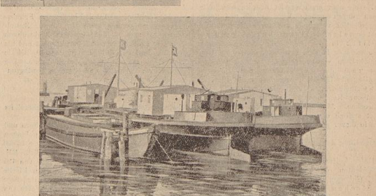
In Bremerhaven wurden aus ehemaligen Seefahrern durch Um- und Aufbau Wohnhäuser für den freiwilligen Arbeitsdienst geschaffen, die die ersten ihrer Art sind. Diese Wohnhäuser sollen auf der Elbe eingesetzt werden, wo ein Abrüstungs- der Arbeitsfreiwilligen zu große Schwierigkeiten machen würde.
