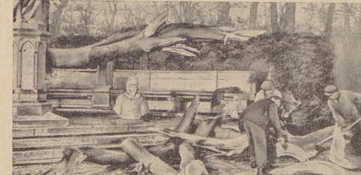
Der schwere, orkanartige Sturm, der große Teile Norddeutschlands heimsuchte, hat u. a. auch die berühmte Stegallee in Berlin schwer getroffen. Ein vom Sturm abgerissener Baumstumpf liegt auf das Denkmal des Kaisers Heinrich, das erhebliche Beschädigungen erlitt.
