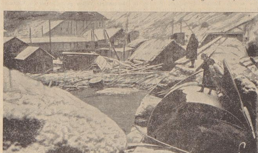
Das erste Originalbild der folgenschweren Arbeiterkataloge im Elbaj. Ein Zuteilungssturz des großen Kraftwerkes in der Nähe von Garmar platze in einer Länge von 80 Metern auf. Die herausbrechenden Wälle führten auf das Kraftwerk und veränderten es in eine Trümmerstätte. Die Bedienung des Kraftwerkes in einer Stärke von neun Mann fand hierbei den Tod.
