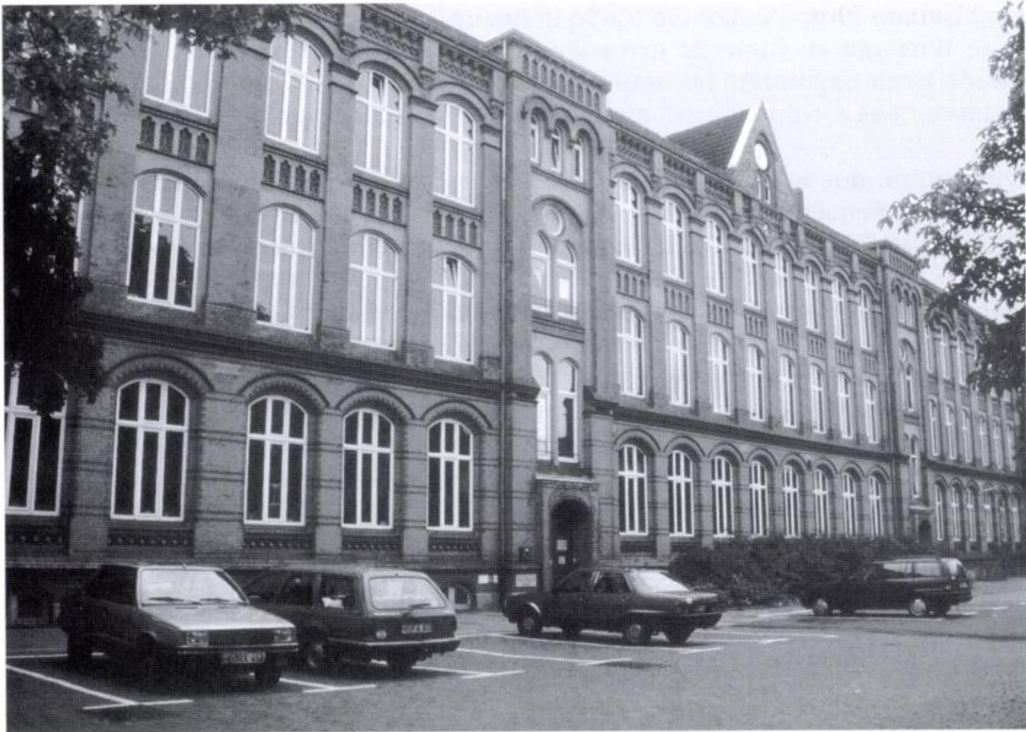
Abb. 6: Ehemalige Schule an der Elisabethstraße, 1894/95 von Flügel erbaut. Die beiden Eingänge für die Knaben- und die Mädchenschule.
