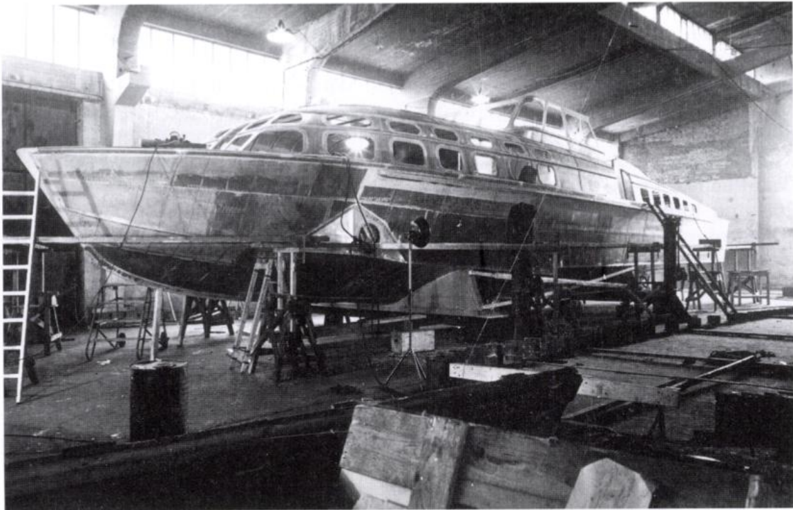
Abb. 3: Der Bootskörper der BREMER PIONIER bei Focke-Wulf in Bremen im Bau. (Foto: Archiv Elbschiffahrtsmuseum Lauenburg/Elbe)
