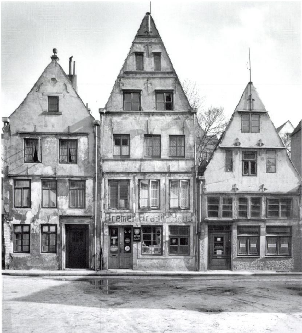
Abb. 3: Ansicht Schnoor 14-16 (rechts Schnoor 14) nach Abbruch der gegenüberliegenden Häuser Schnoor 32-33 (Neubau Fischeramtshaus 1972). (Foto: Landesamt für Denkmalpflege)
