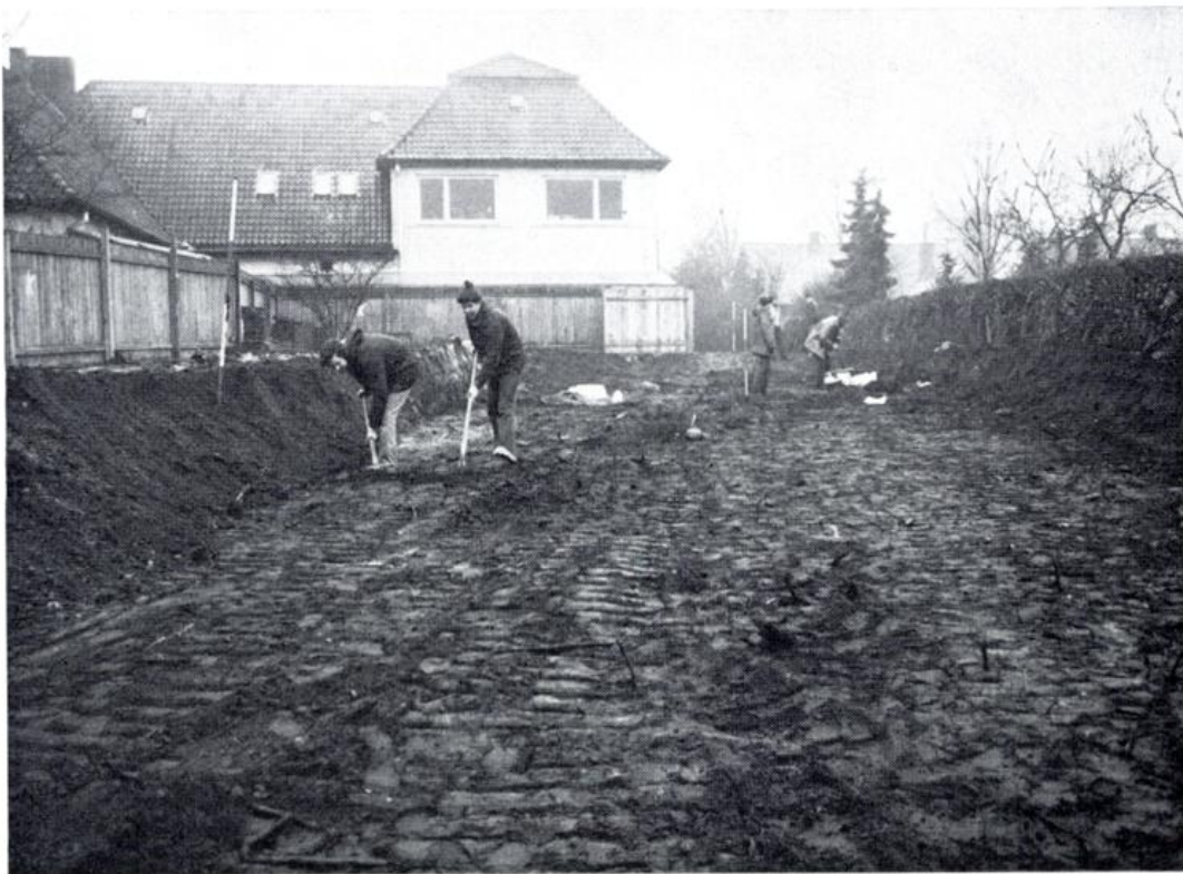
Abb. 2 Bremen-Rekum. Rekumer Str. 11. Oben: Grabungsfläche 1976 in der Pipelinetrasse. Unten: Grabungsfläche 1976, Blick nach Westen.
