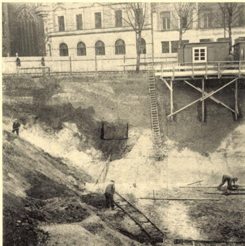
Abb. 2 Spitzgrabenprofil und Mauerreste auf der Westseite. (Umriß nachgezogen)
