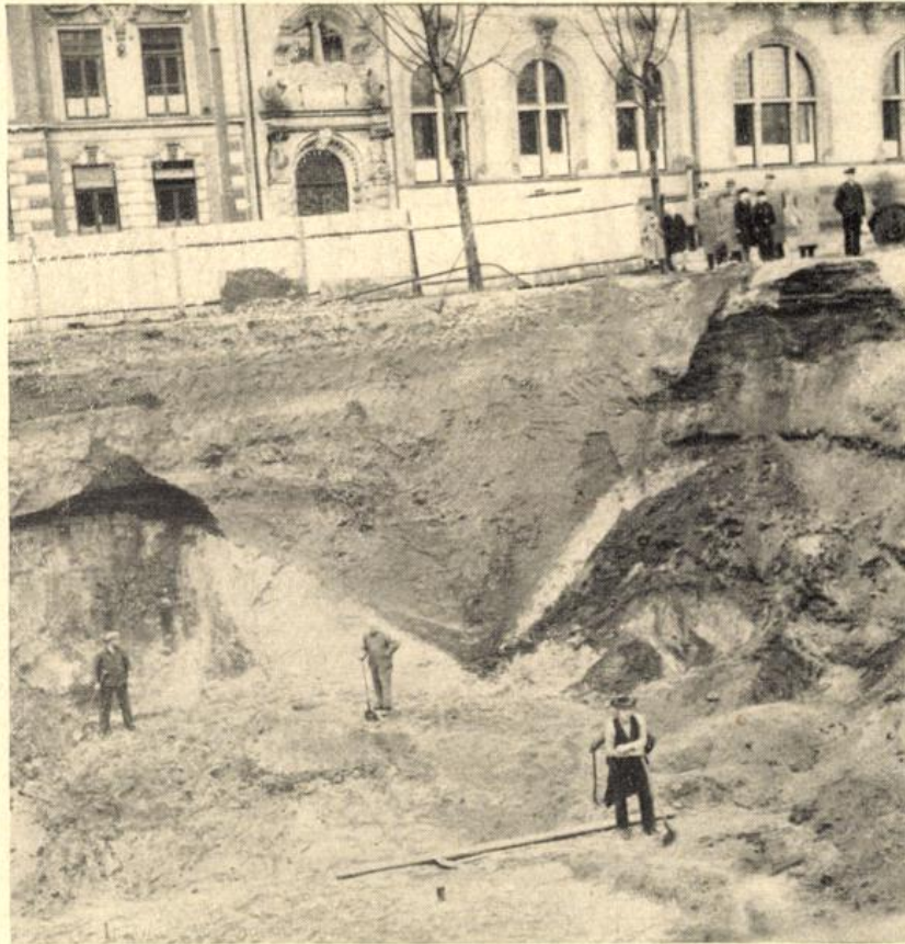
Abb. 1 Spitzgrabenprofil auf der Ostseite der Domshof-Baugrube.
