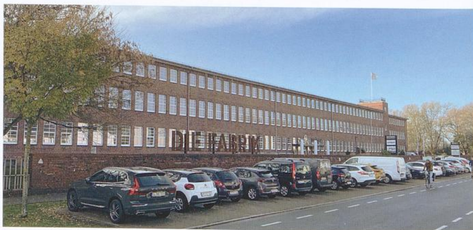
Hermann-Ritter-Straße, ehemalige Brinkmann-Fabrik nach der Sanierung, 2022
