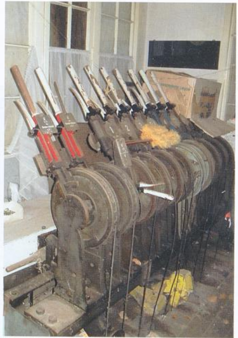
Bahnhof Bremen-Blumenthal, Hebelbank des mechanischen Stellwerks, 2012
