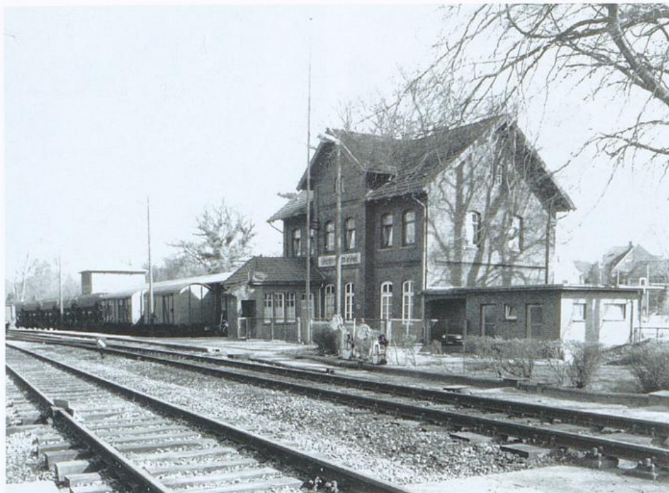
Bahnhof Bremen-Blumenthal, Empfangsgebäude und ehemaliger Güterschuppen von den Gleisen aus gesehen, 1988
