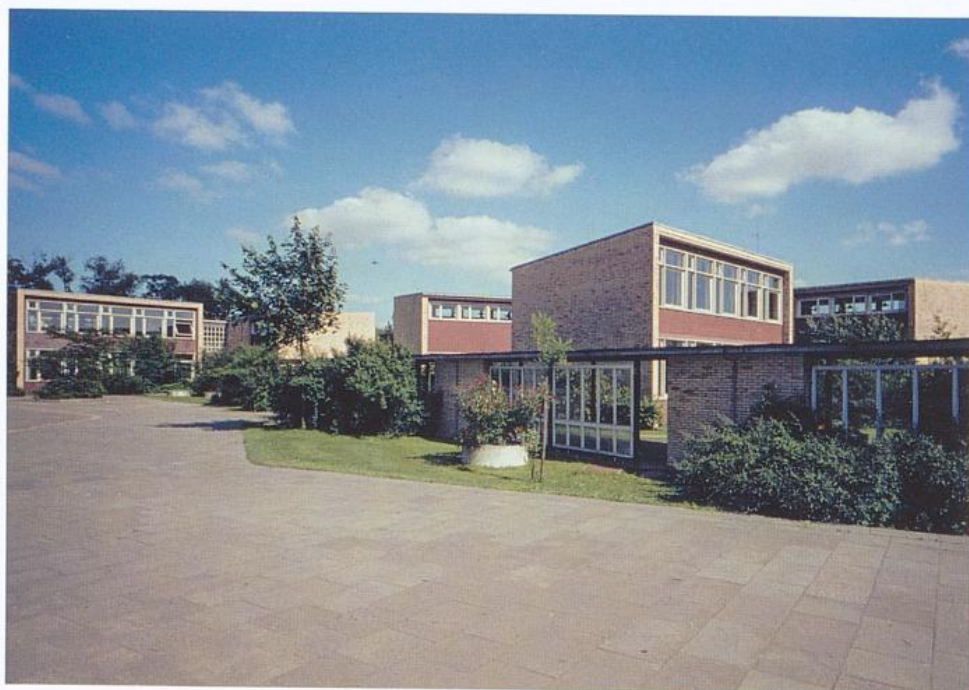
Ursprünglicher Zustand der Fassaden nach Fertigstellung der ersten Pavillons 1957
