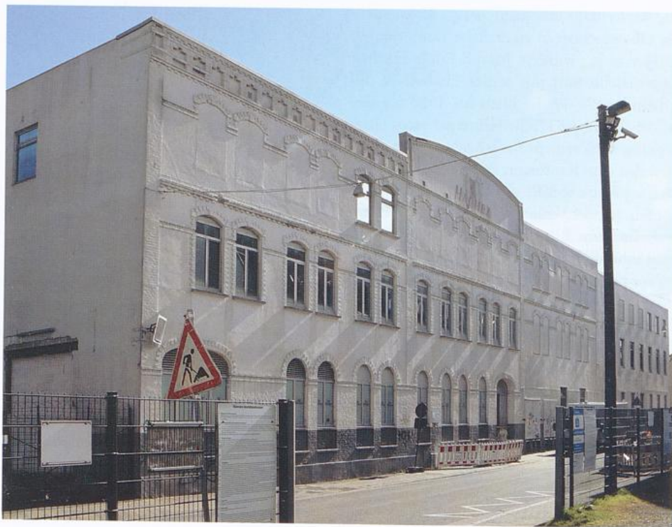
Produktionsgebäude der Chocoladen-Fabrik Hachez & Co an der Großen Annenstraße, 2021
