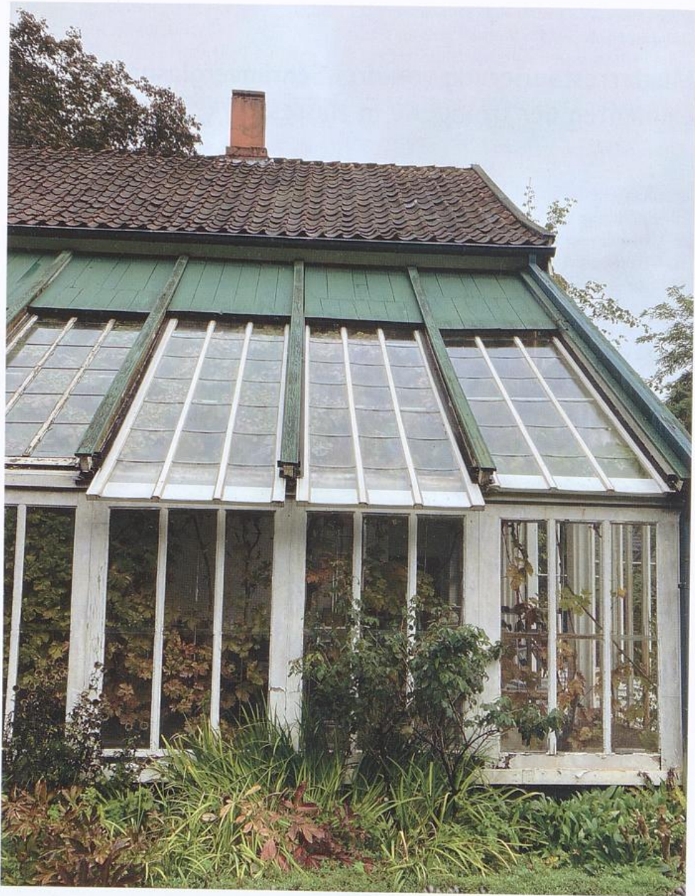
Die drei Schrägverglasungselemente der Musterrestaurierung
