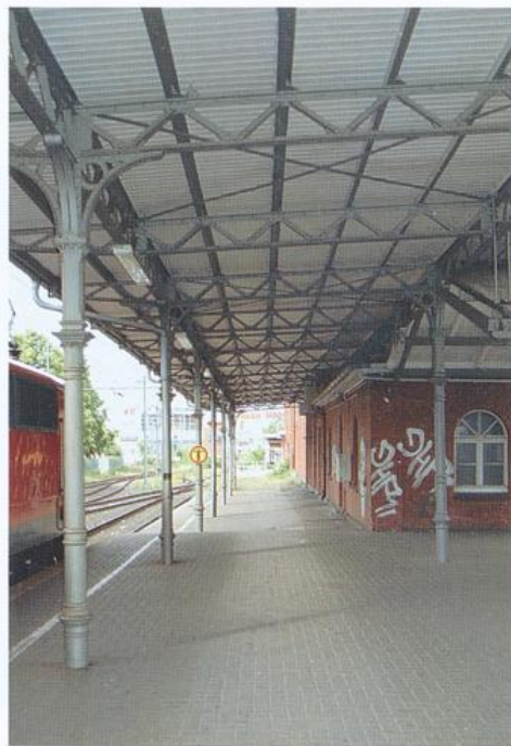
Bahnhof Bremen-Vegesack, historische Bahnsteigüberdachung, 2006
