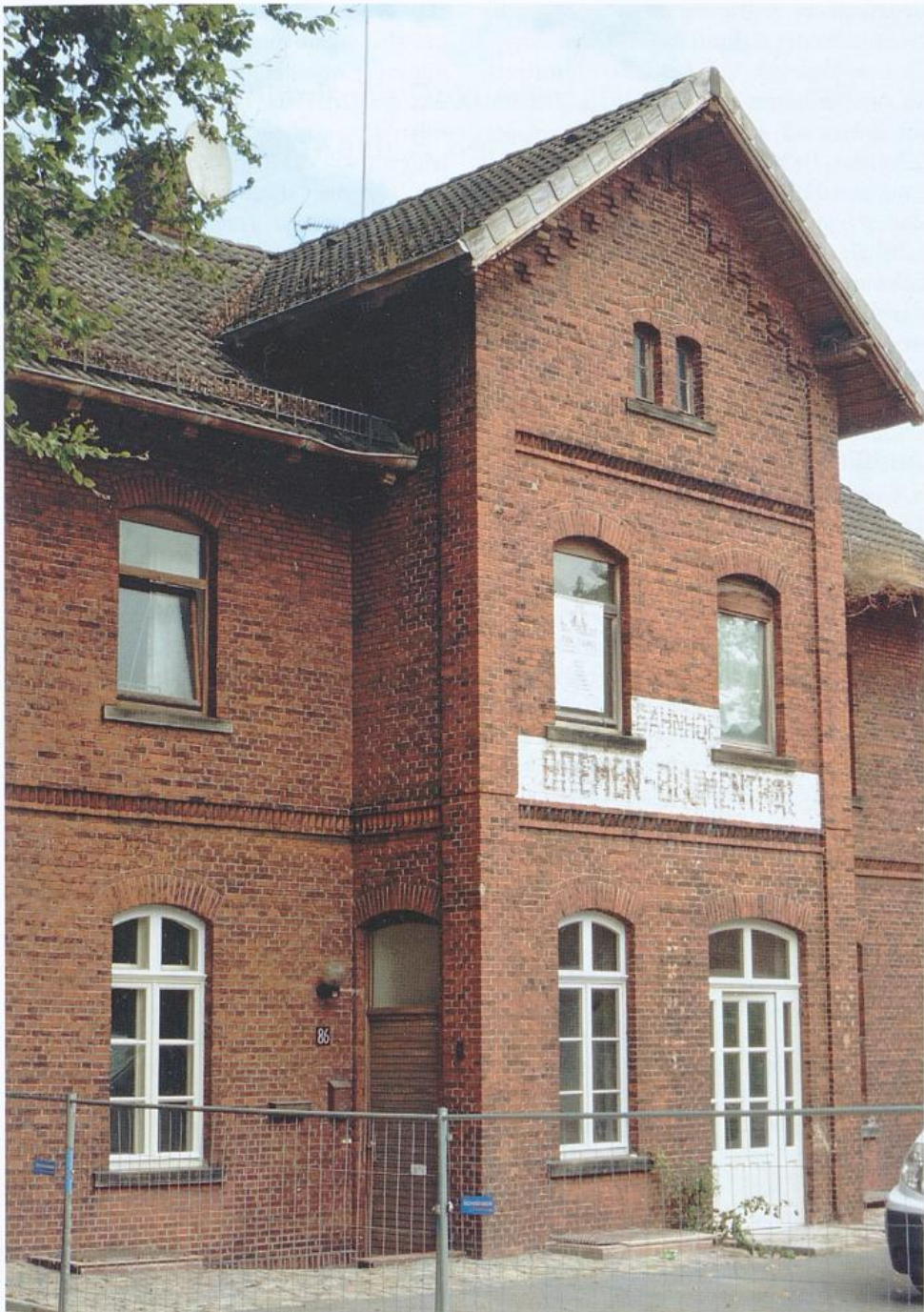
Bahnhof Bremen-Blumenthal, Eingangsbereich des Empfangsgebäudes während der Sanierung, 2022
