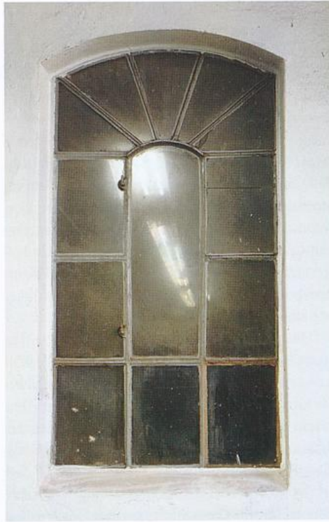
Silberwarenfabrik Wilkens, historisches Metallsprossenfenster der Produktionshallen, 2020
