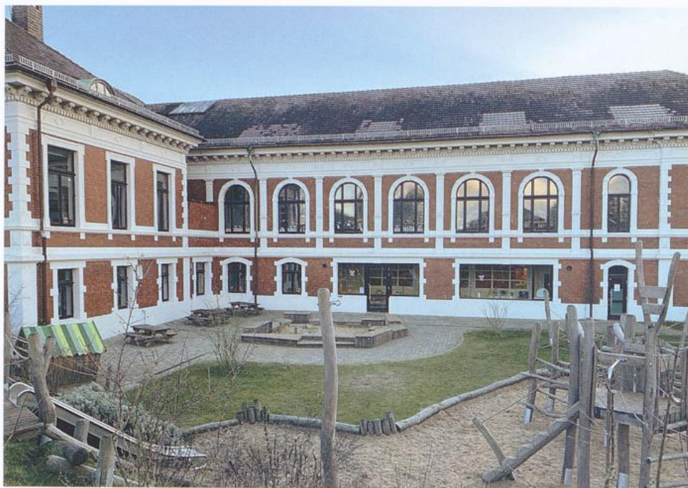
Die Villa der ehemaligen Kaufmännischen Verwaltung als Bürohaus und Kita
