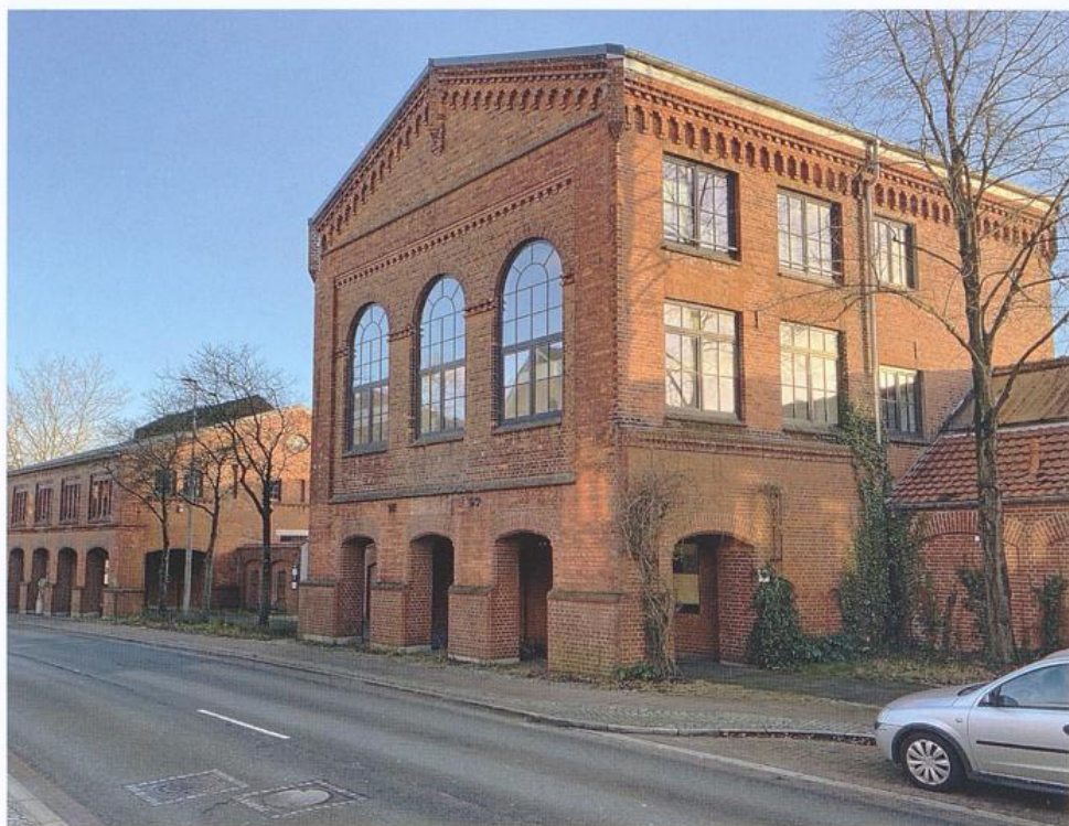
Sanierte und bereits umgenutzte Gebäude an der Landrat-Christians-Straße
