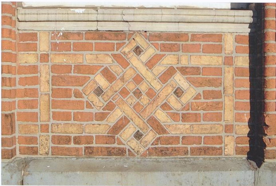
Bahnhof Bremen-Vegesack, Detail einer Fensterbrüstung am Empfangsgebäudes, 2007
