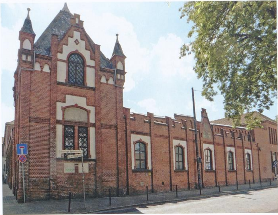
Silberwarenfabrik Wilkens, Schauffassade an der Hemelinger Bahnhofstraße, 2020
