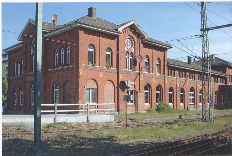
Bahnhof Bremen-Vegesack, Südostansicht des Empfangsgebäudes, 2009
