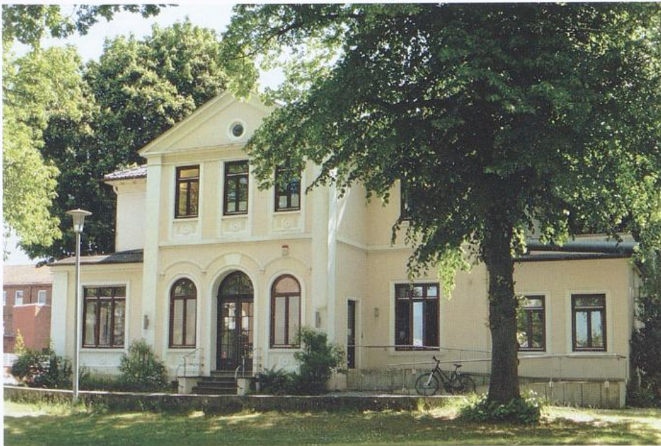
Ehem. Villa Wilkens, Fassadenansicht an der Hemelinger Bahnhofstraße, 2020
