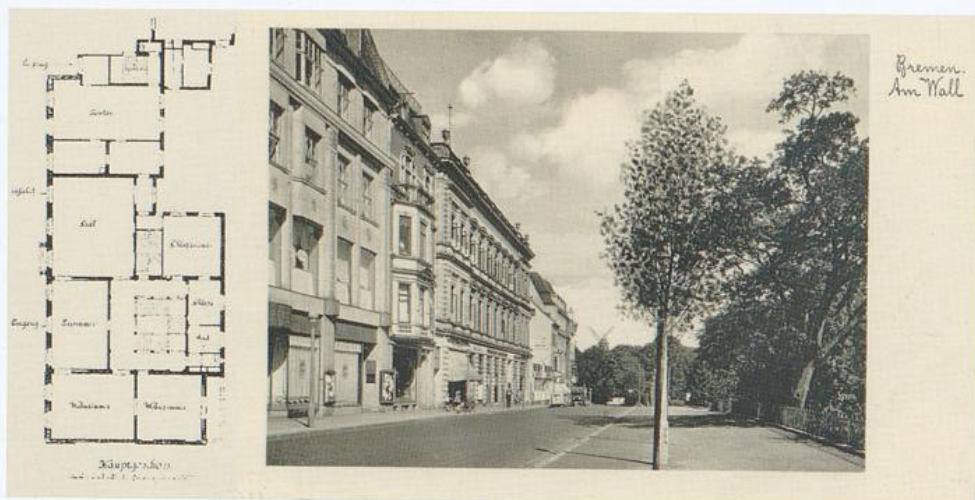
Wohnhaus Johannes Fritze und Kontor von W. A. Fritze & Co., Am Wall 154/156, 1876. Die Postkarte zeigt die Erdgeschosszone nach dem Umbau 1927; 1950 stark verändert wiederaufgebaut als Securitas-Haus
