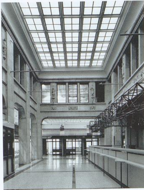
Die ehemalige Kassenhalle der J. F. Schröder Bank im Jahr 2000
