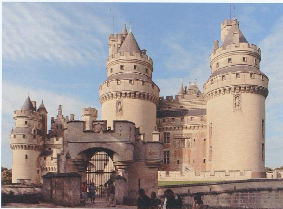
Schloss Pierrefonds, Eingangssituation
