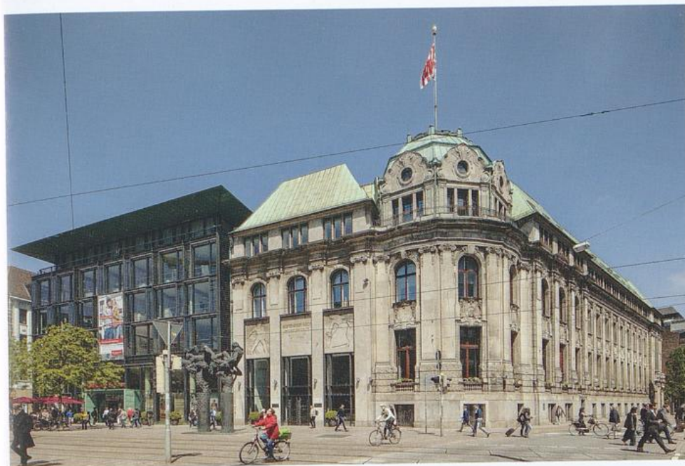
Die Sparkasse Am Brill mit neuem Erweiterungsbau, aktuelle Aufnahme
