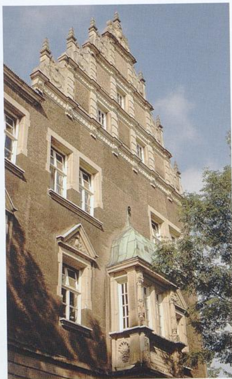
Realgymnasium Am Barkhof, Giebel
