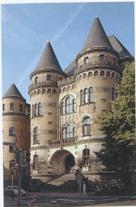
Gerichtsgebäude, ehem. Eingang Buchtstraße
