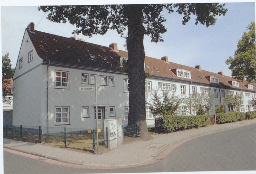
Humannviertel, Fürsorgewohnungen im III. Bauabschnitt, Ansicht Wischhusenstraße/Ecke Am Kammerberg
