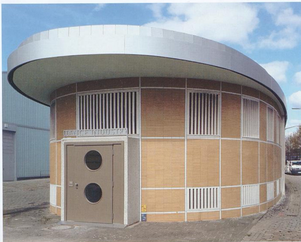
Zollamt Hansator, Kleingüterabfertigung. Haupteingang nach der Sanierung
