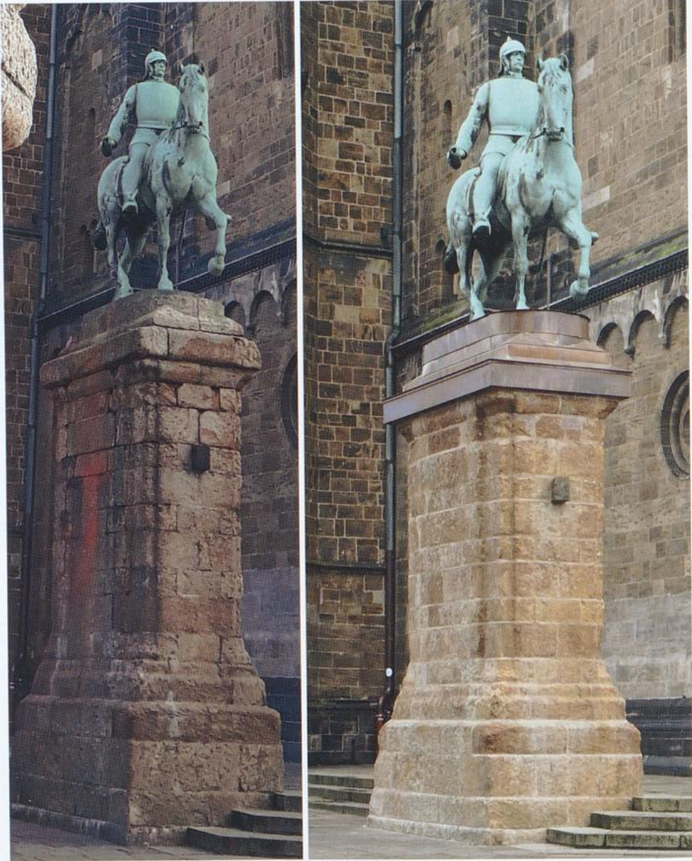
Zustand vor und nach Abschluss der Sanierung des Bismarck Denkmals im Jahr 2020
