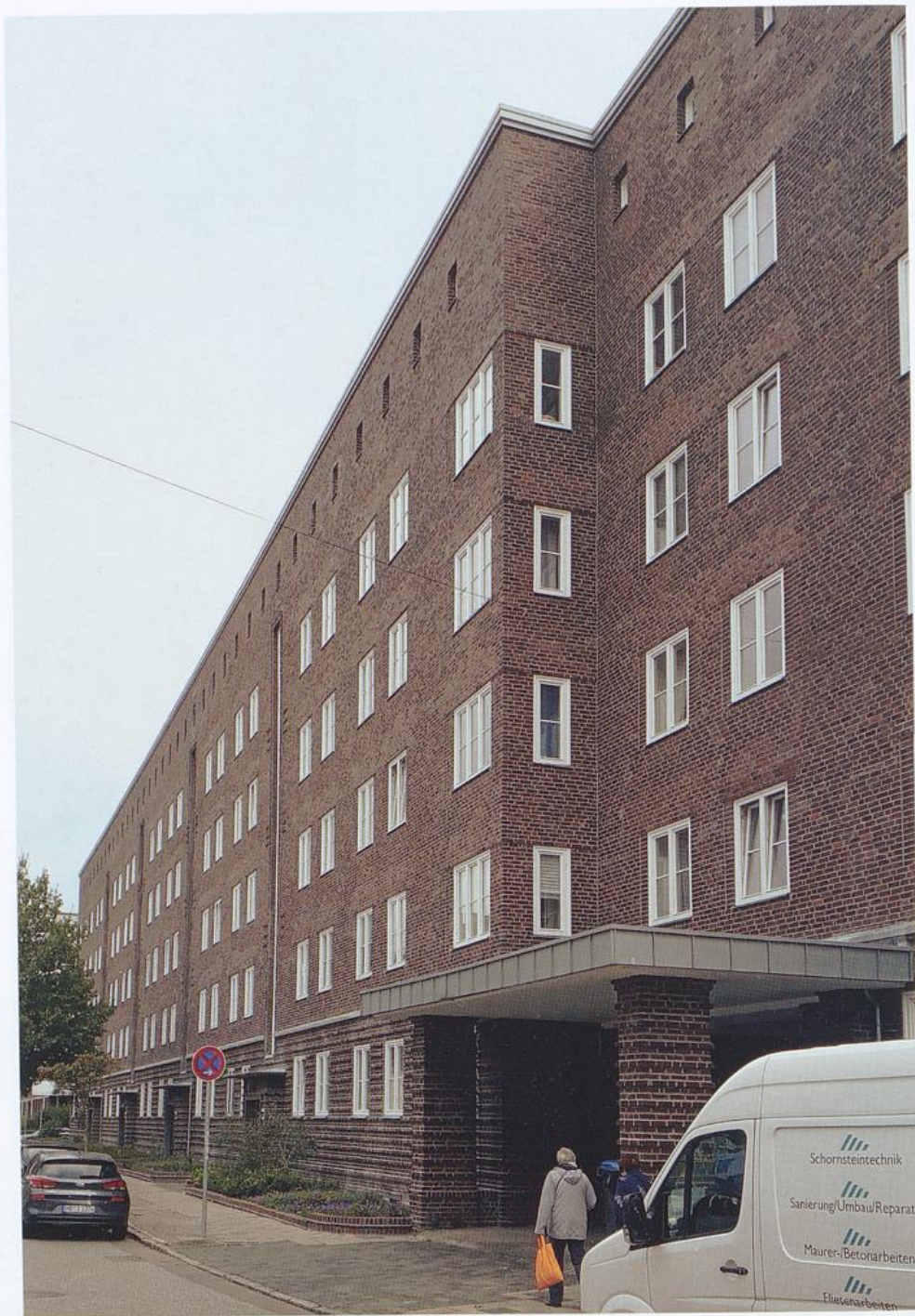
Fassade an der Bürgermeister-Smidt-Straße nach der Sanierung
