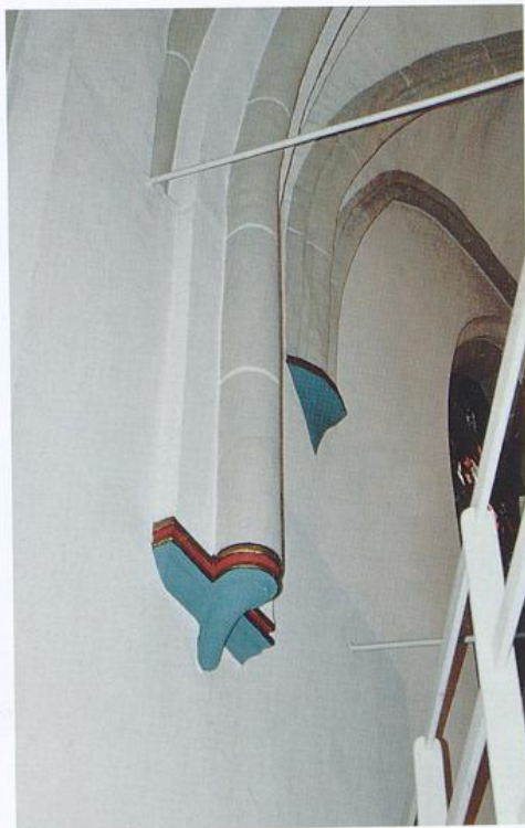
St. Johann, abgekragte Dienstkonsole (Scheidbogen), Westwand, vermutlich über mittelalterlicher Orgelempore
