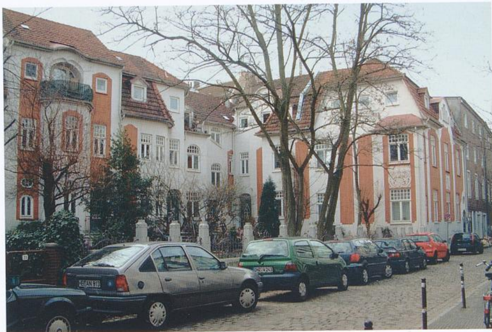
Weberstraße, Ensemble, genannt »Wiener Hof«, Arch. Rauschenberg & Müller
