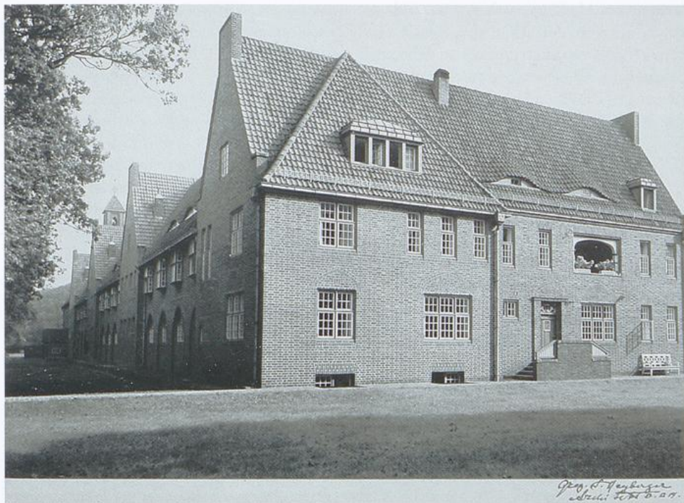
Südwestecke der Anlage
