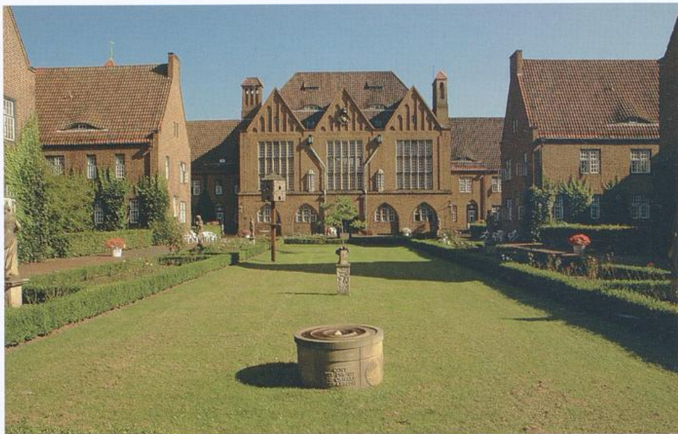
Innenhof des Altenheims von Süden zum Mittelbau
