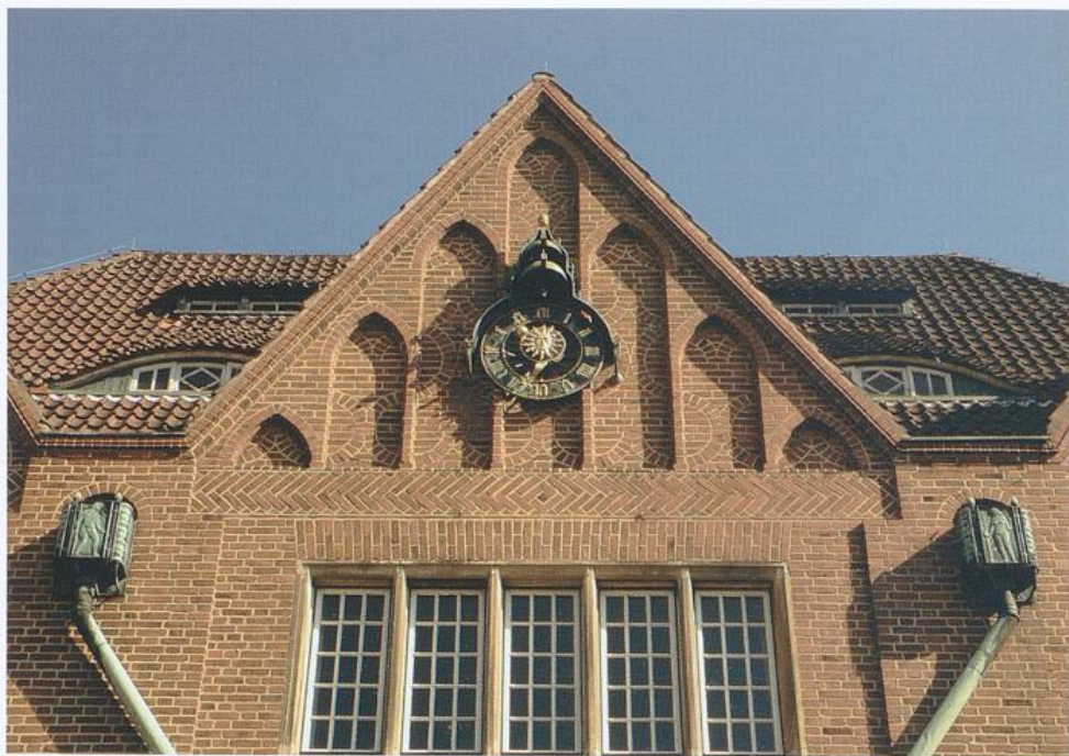
Dekoratives Mauerwerk am Giebel des Mittelbaus
