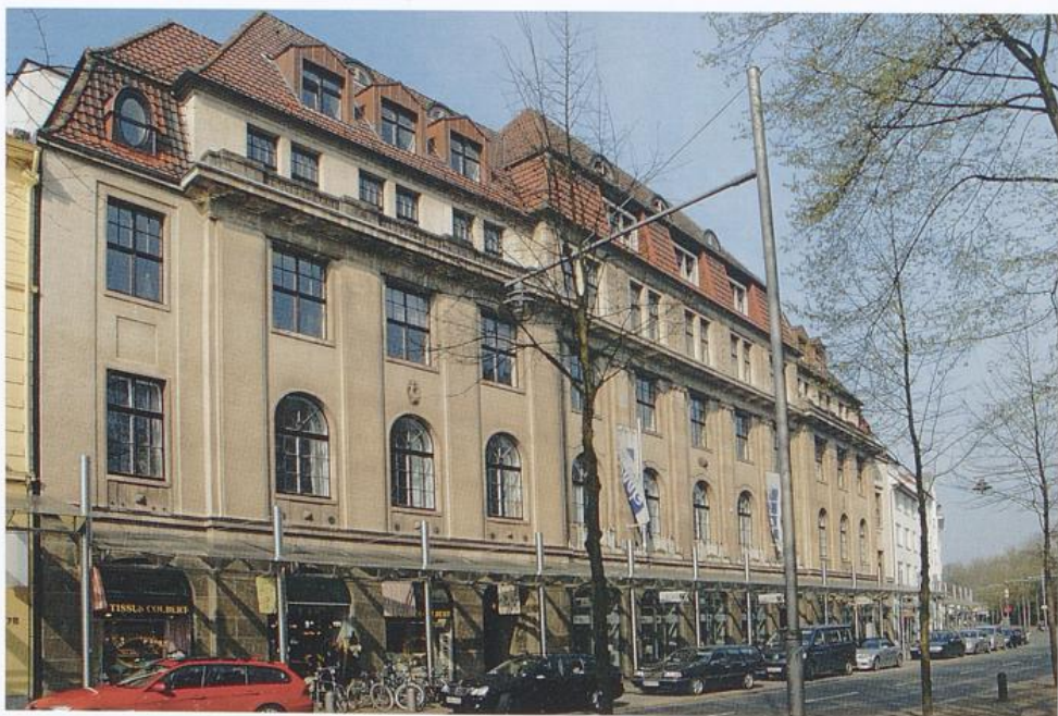
Geschäftshaus Stallmann & Harder, Am Wall 175-177, Arch. Behrens & Neumark
