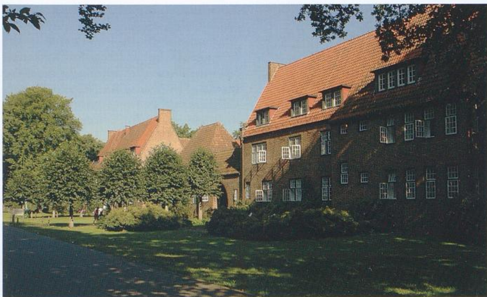
Eingangssituation, Ansicht von Südosten
