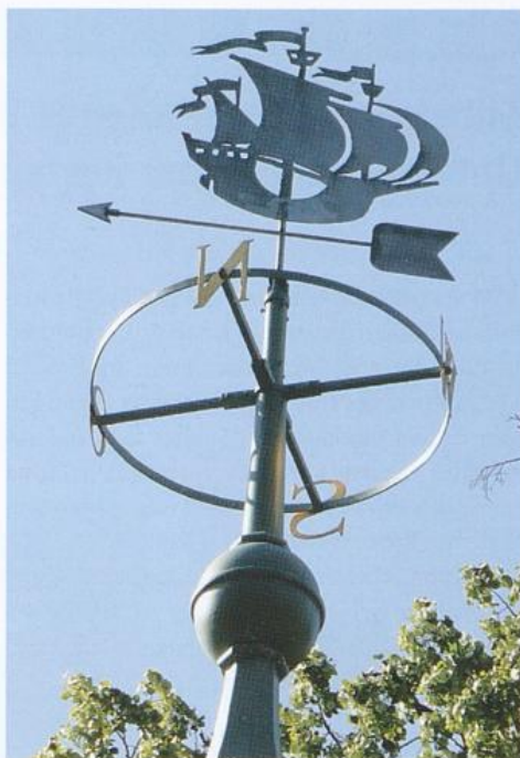
Turmspitze und Windspiel nach der Erneuerung
