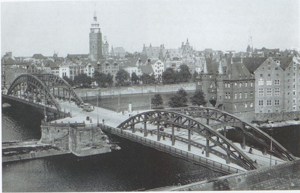
Kaiserbrücke in Bremen nach Entwurf von Emil Högg, ausgeführt von der Bauabteilung der Krupp AG; das Gelände an der Verlängerung der Teerhofinsel stammt von der Vorgängerbrücke, Aufnahme um 1925
