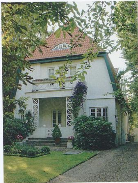
Haus Herbst, Schwachhauser Heerstraße 335, Arch. Runge & Scotland
