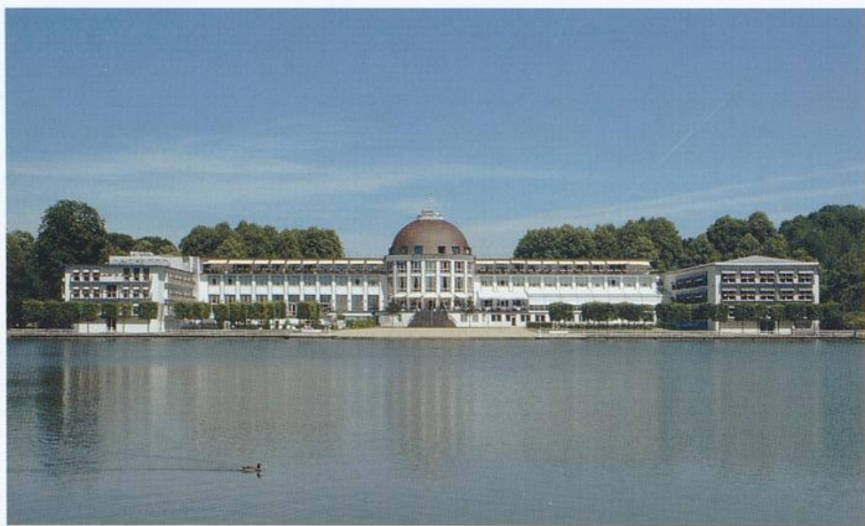
Ehemaliges Parkhaus, heute Parkhotel, Aufnahme 2005
