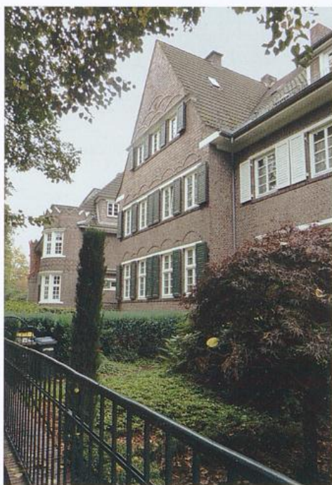
Doppelhaus Schwachhauser Ring 2-4 (Hintergrund) und Häuser Schwachhauser Ring 6 und 8
