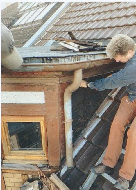
Erker nach Abnahme der Verkleidung
