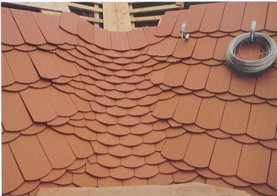
Wiederherstellung der eingebundenen Kehle bei der Neudeckung des Daches
