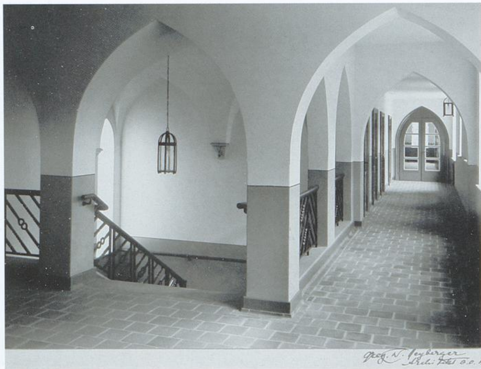
Treppenhaus und Flur im östlichen Wirtschaftsflügel, später Frauenabteilung
