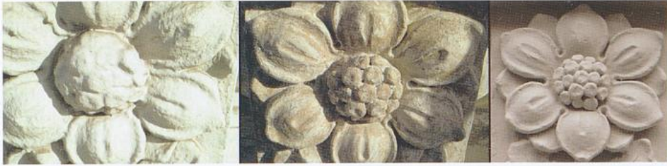
Stuckelement mit Altanstrichen, nach Entfernung des Anstrichs und nach Auftrag eines mineralischen Farbsystems
