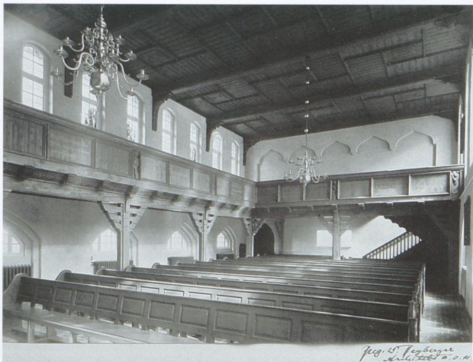
Innenraum der Kirche nach Nordwesten 1912
