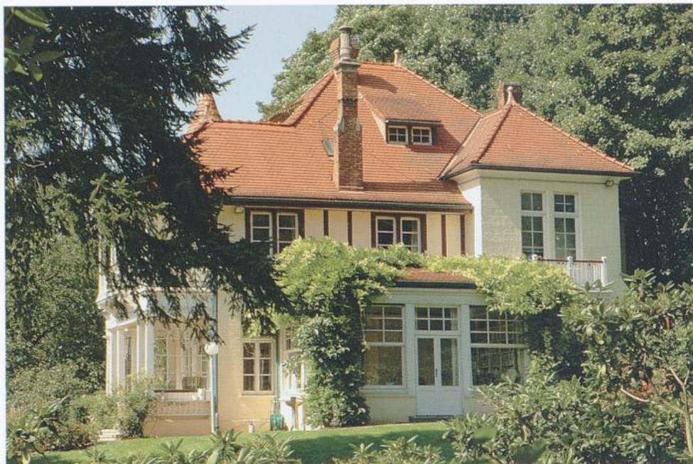
Bremen-Lesum, Haus Schwalbenklippe, Arch. Wellermann & Frölich
