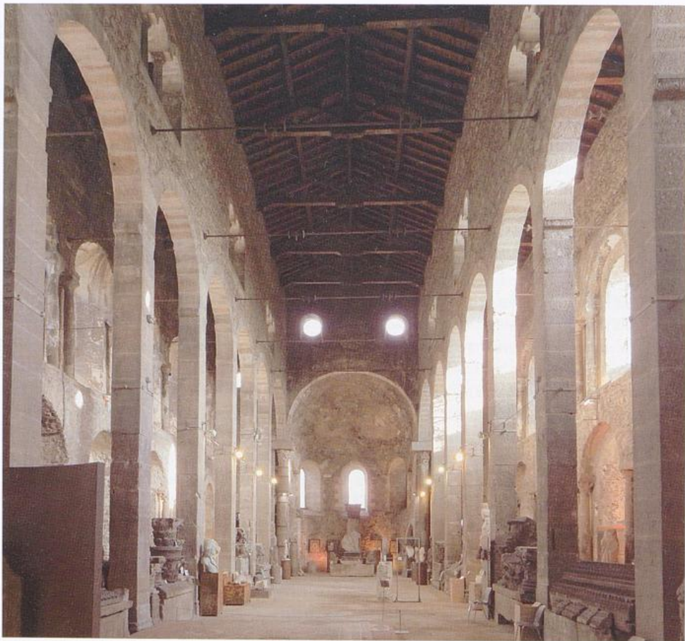
Vienne (Département Isère): Spätantiker Saalbau, seit 570 als Kloster genutzt, mit späterem Umbau zur Dreischiffigkeit mit gleich hohen Schiffen
