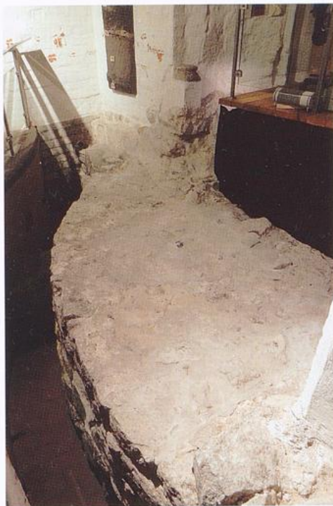
Bremen, Dom: Apsisfundament Südquerhaus
