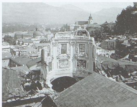
Der zerstörte Dom Santino Solaris in einer Aufnahme von 1945, im Hintergrund rechts das Benediktinen-Frauenstift Nonnberg, links die Kajetanerkirche
