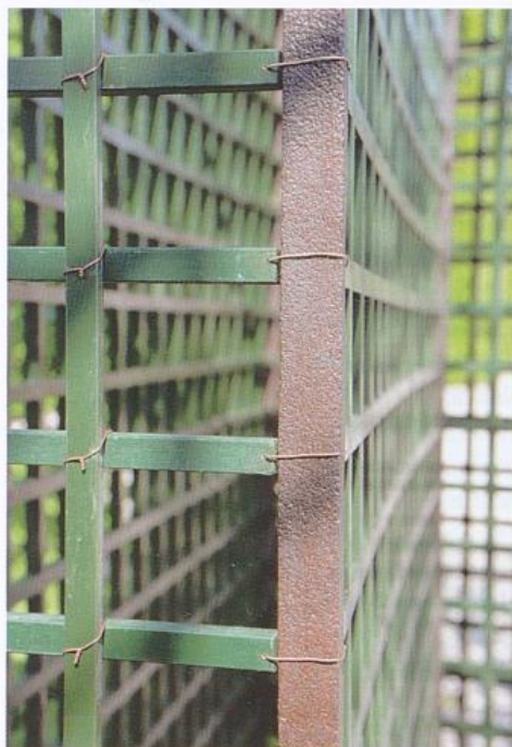
Detail der fertig installierten Konstruktion. Grün beschichtete Holzbereiche, die Verdrahtung wurde mit verkupferten Eisendraht ausgeführt, die Stützen mit einem Korrosionsschutzöl beschichtet. An den Fußpunkten dient ein modifizierter Polyesterdickschichtlack in mehrfachem Auftrag als Korrosionsschutz im Staunässebereich
