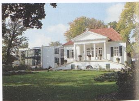
Holdheim, Villa mit Vorfahrt und Ergänzungsbau
