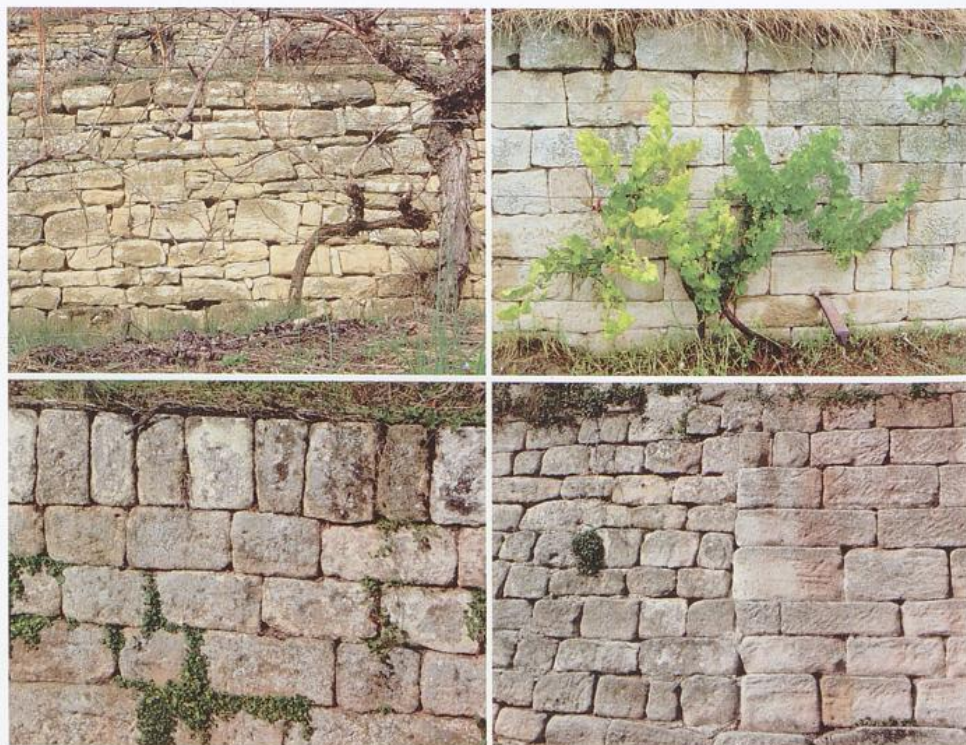
Abb. 5 a–d: Verschiedene Mauerformen und Mauerkronen aus Weinbergen Baden-Württembergs; links unten Mauer mit einer »Rollschicht«, rechts unten mit einer Baunaht
