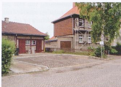
Bad Langensalza, Gräser'sche Arbeitersiedlung, in Parkplätze umgewandelte Vorgärten
