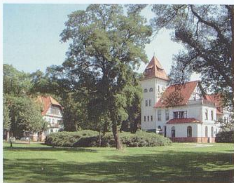
Klinikum Ost (chem. St.-Jürgen-Asyl), ehemaliges Verwaltungsgebäude (rechts) und ehemalige Direktorenvilla
