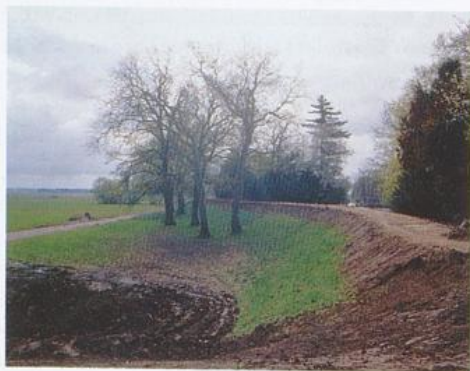
Wörlitzer Anlagen, Hochwasserertüchtigung des Elbdeiches, 2011
