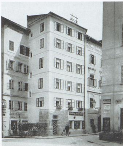
Daucherwirt, Kaigasse. Bei der Fassaden-erneuerung wurde die alte Stadtmauer, auf der das Wohnhaus errichtet wurde, freigelegt
