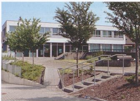
Fulda, Platz der Weißen Rose, 2011. Blick von der unteren Terrasse auf das modernisierte Sparkassengebäude sowie die Detailgestaltung der jüngsten Veränderungen
