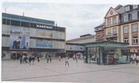
Fulda, Universitätsplatz, 2011. Blick auf das Karstadtgebäude nach Plänen von Sep Ruf. Erkennbar der neue Bodenbelag sowie der modern gestaltete Abgang zum Parkhaus unter dem Platz
