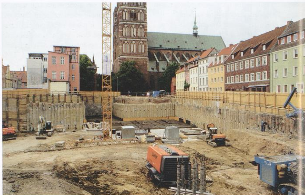
Stralsund, Baustelle in der Altstadt, 2011
