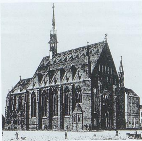
Die St.-Johannis-Kirche nach der Restaurierung 1888
