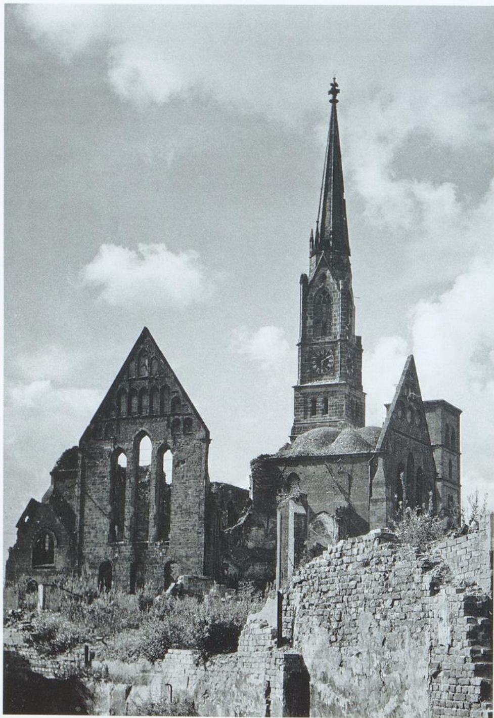
Ruine der Kirche, rechts das Gewölbe des nördlichen Querhausarmes
