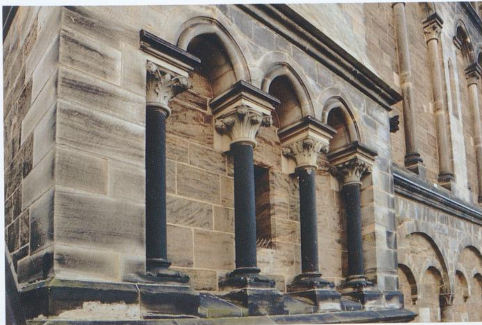
Abb. 1: Natursteinbestand des Bremer Doms. Rücklagen aus Portasandstein, Eckquaderungen aus Wealden-Sandstein, Kapitelle und Säulen aus Obernkirchener Sandstein
