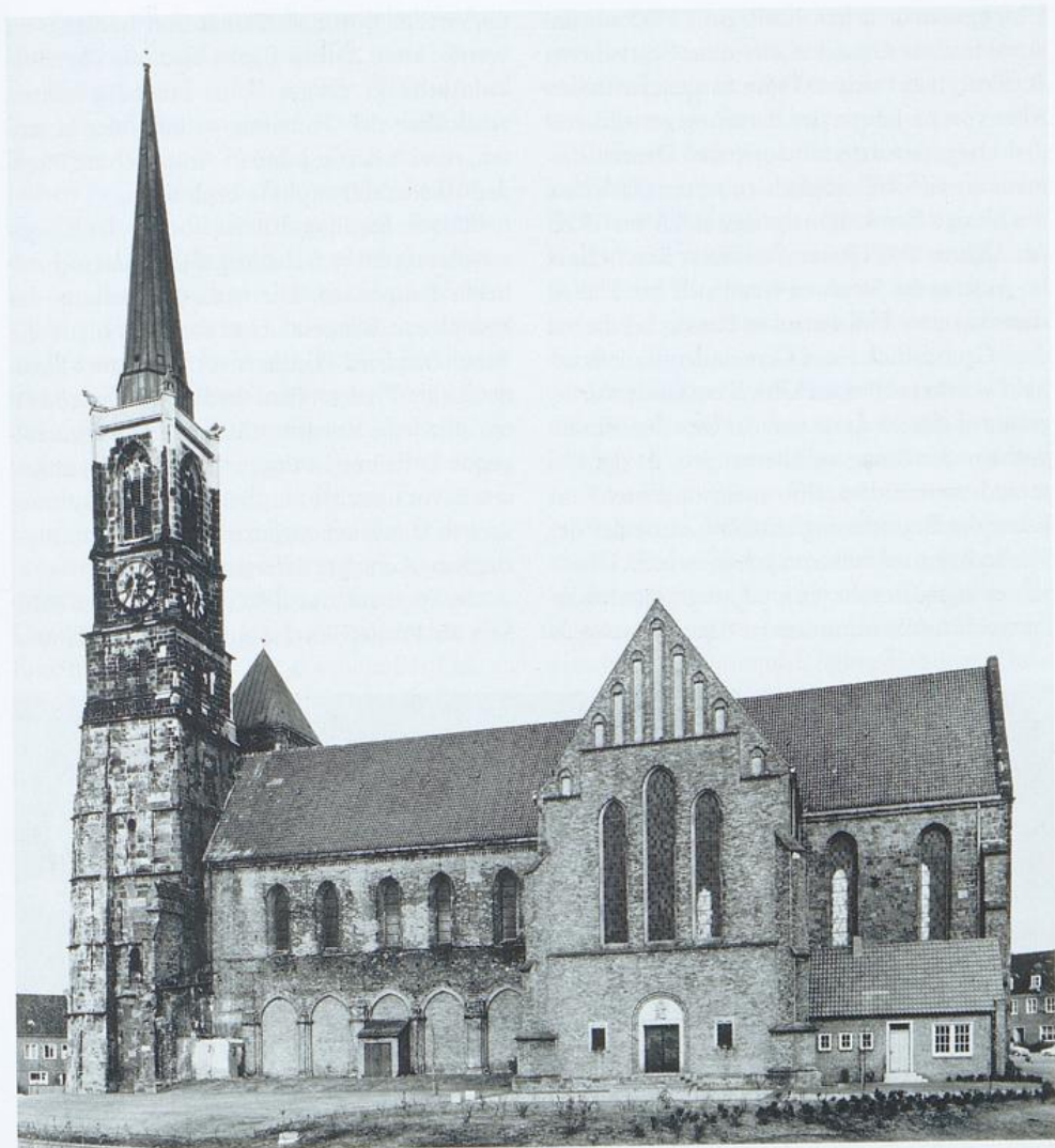
Südseite der Kirche nach dem Wiederaufbau, rechts vom Querhaus die neue Sakristei
