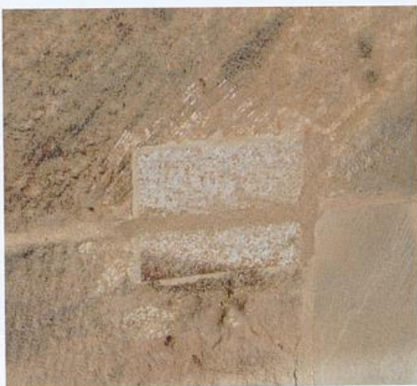
Abgeschlossene Reparatur mit Sandstein- Vierung
