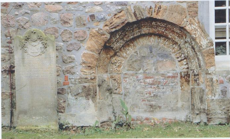
Das zugesetzte Südportal des Langhauses, ehemals, vermutlich bis 1928, wie der gegenüberliegende Eingang für ein Fenster genutzt; daneben der Grabstein für Johann Honne
