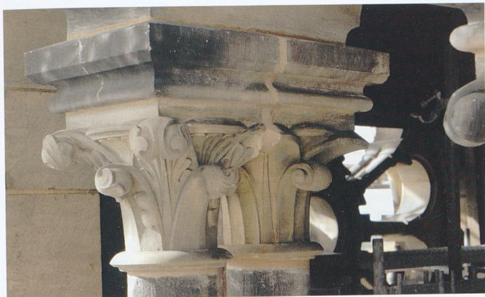
Reparierte Säulenkapitelle am Nordturm
